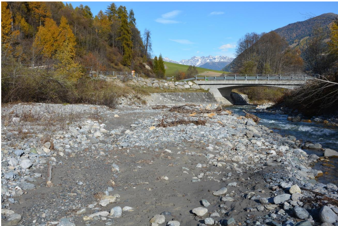
Brücke über den Rom bei Sta. Maria mit Ablagerungen von Geschiebeeinträgen aus den Seitenbächen Muranzina und Aua da Vau 02.11.2014, dp
